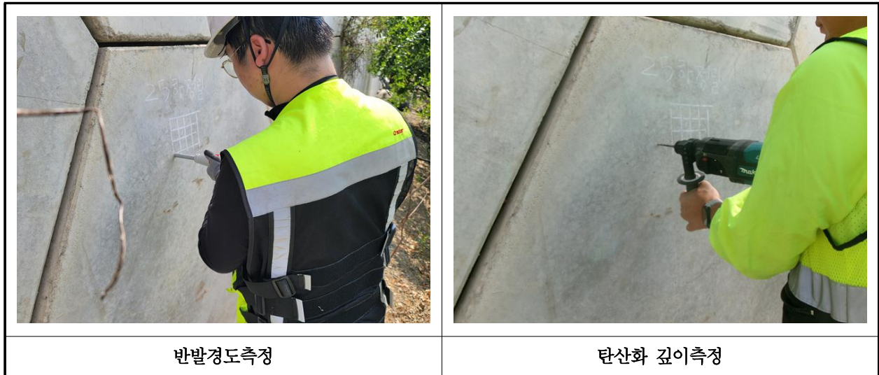
【사진 15.4.1】 재료시험 조사 전경
