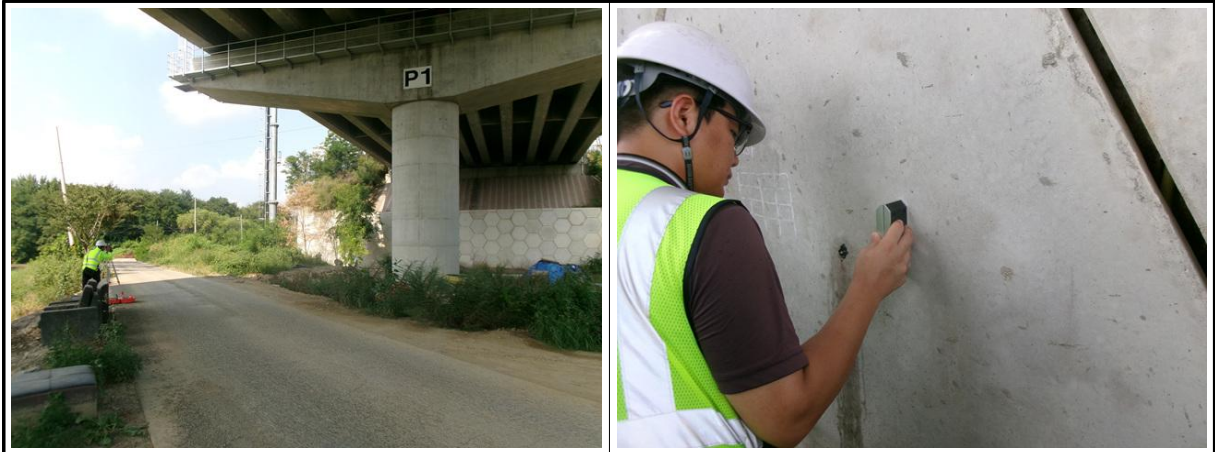
【사진 15.4.2】측량작업 전경
