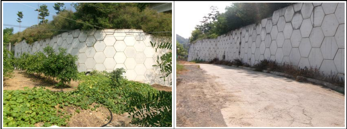
【사진 15.3.1】 지반, 기초부 전경
